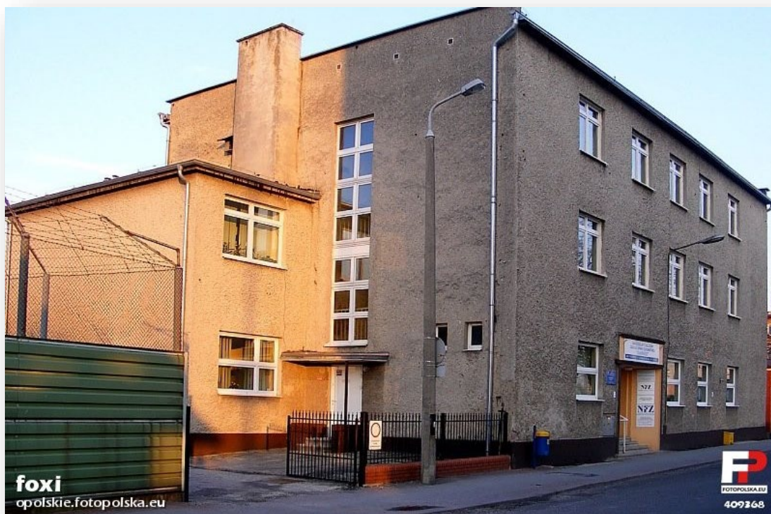
Pierwsza lokalizacja Oddziału w Przychodni Rejonowej Nr 2 na Zaodrzu przy ul Licealnej.
