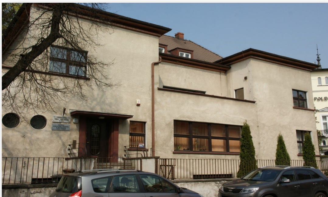
Budynek Opolskiej Izby Lekarskiej przy ul. Grunwaldzkiej 23, w którym mieścił się Oddział Głównej Biblioteki Lekarskiej w Opolu.
